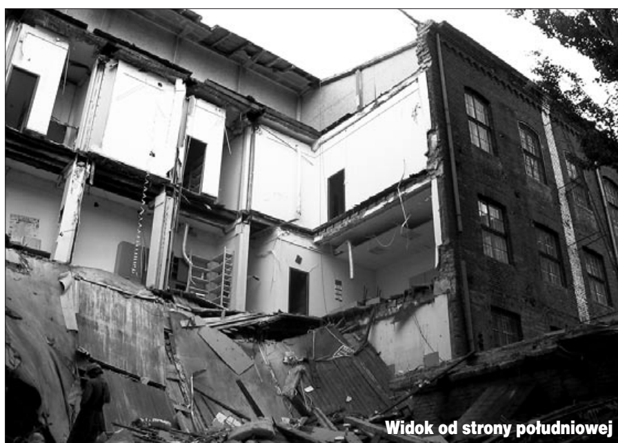
Budynek przy pl. Zwycięstwa 2 po katastrofie
