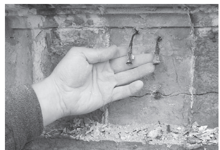
Fot. 7. Detal sztukatorski: a) tracący zespolenie z gzymsem, b) łatwo dający się usunąć, c) skorodowane gwoździe stanowiące jego mechaniczne zakotwienie
