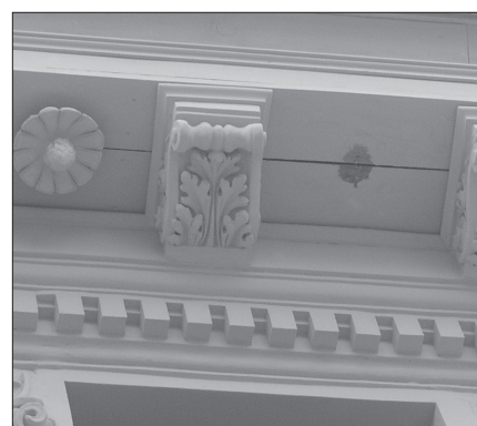
Fot. 11. Ślad po brakującym elemencie sztukatorskim drewnianego gzymsu
