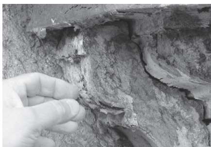
Fot. 7. Detal sztukatorski: a) tracący zespolenie z gzymsem, b) łatwo dający się usunąć, c) skorodowane gwoździe stanowiące jego mechaniczne zakotwienie
