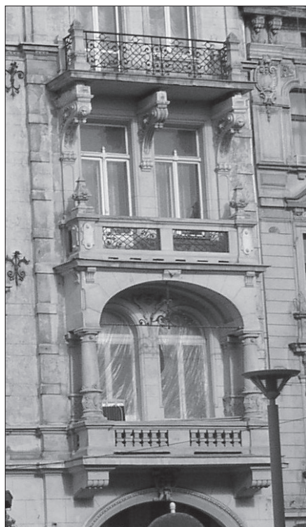
Fot. 2. a) Balkon remontowany w 1999 r., b) Brakujący element obudowy wspornika balkonu trzeciego piętra – przyczyna wypadku w maju 2005 r.
