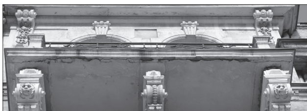
Fot. 4. a) Arkusze blachy obróbki blacharskiej łączone na zaprawę cementową, b) Krawędź balkonu zniszczona przez pęczniejącą deskę drewnianą
