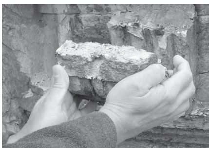
Fot. 7. Detal sztukatorski: a) tracący zespolenie z gzymsem, b) łatwo dający się usunąć, c) skorodowane gwoździe stanowiące jego mechaniczne zakotwienie
