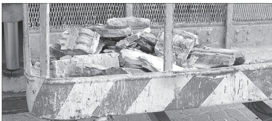
Fot. 9. Kilkadziesiąt kilogramów luźnych detali sztukatorskich usuniętych w trakcie wizji lokalnej w maju 2005 r.
