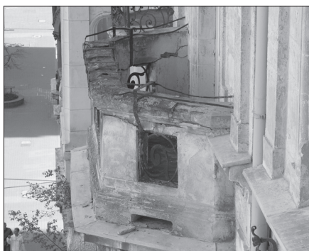
Fot. 6. Balustrada tarasu nad wykuszem prowizorycznie zabezpieczona stalowymi elementami co najmniej kilkadziesiąt lat temu, a) widok ogólny z luźno leżącymi fragmentami tynku na okapie, b) zbliżenie na górną część balustrady
