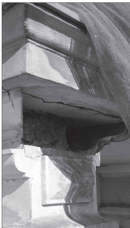
Fot. 2. a) Balkon remontowany w 1999 r., b) Brakujący element obudowy wspornika balkonu trzeciego piętra – przyczyna wypadku w maju 2005 r.
