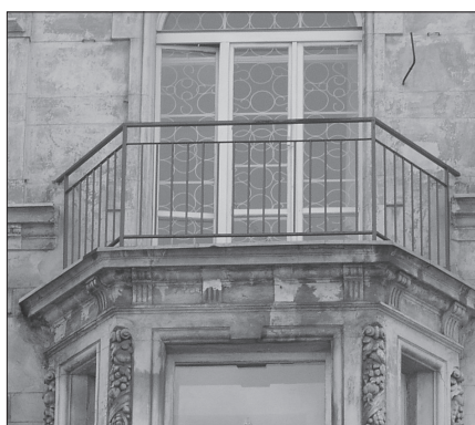
Fot. 10. Nowa balustrada stalowa w miejscu oryginalnej rozebranej w końcu 2005 r.
