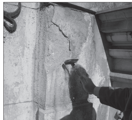
Fot. 8. Naprawy starego tynku wapiennego za pomocą mocnej zaprawy cementowej
