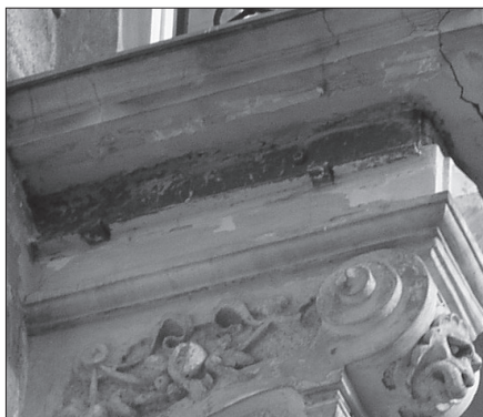
Fot. 3. a) Wspornik balkonu po zdemontowaniu elementu sztukatorskiego źle umocowanego do konstrukcji, b) Fragment sztukaterii kruszący się w rękę
