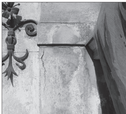
Fot. 8. Naprawy starego tynku wapiennego za pomocą mocnej zaprawy cementowej
