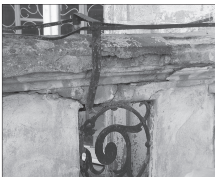
Fot. 6. Balustrada tarasu nad wykuszem prowizorycznie zabezpieczona stalowymi elementami co najmniej kilkadziesiąt lat temu, a) widok ogólny z luźno leżącymi fragmentami tynku na okapie, b) zbliżenie na górną część balustrady
