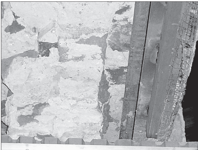
Fot. 2. Osadzenie belek nadprożowych w gniazdach muru bez zabezpieczenia przed ich obrotem wzdłuż osi podłużnej
