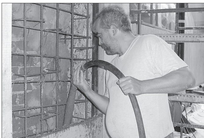
Fot. 6. Betonowanie pionowych elementów ramy żelbetowej
