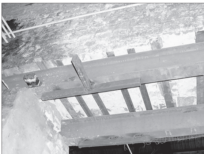
Fot. 4. Zabezpieczenie nadproża na czas prowadzenia robót wzmacniających
