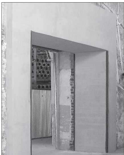
Fot. 7. Widok wykonanego wzmocnienia konstrukcji w postaci żelbetowej ościeżnicy
