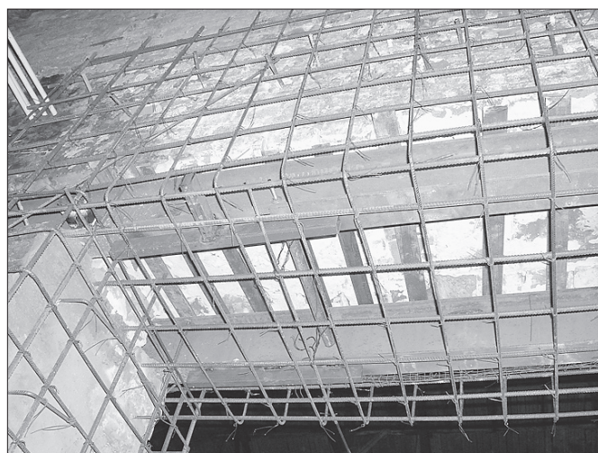
Fot. 5. Zbrojenie konstrukcji wzmacniającej
