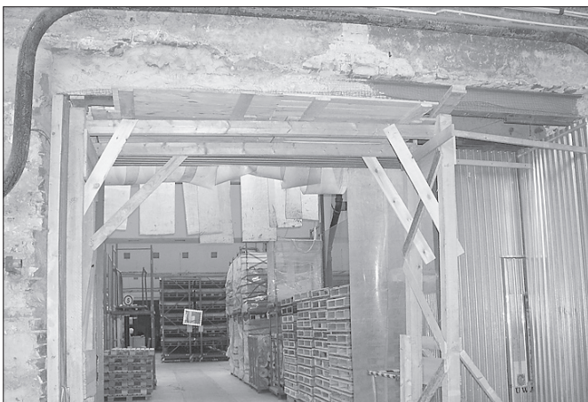
Fot. 1. Prowizoryczne zabezpieczenie nadproża wykonane przez użytkownika budynku w maju 2005 r.
