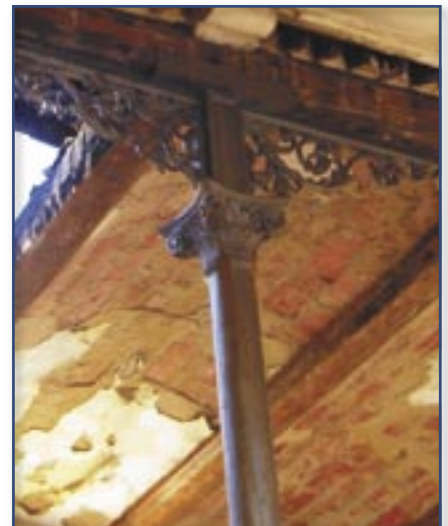
Rys. 4. Konstrukcja stropu odcinkowego z drewnianymi belkami (Ciechocinek)
