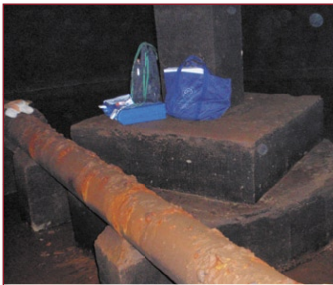
Zbiornik nr 2 – podstawa słupa środkowego i skorodowany rurociąg technologiczny
