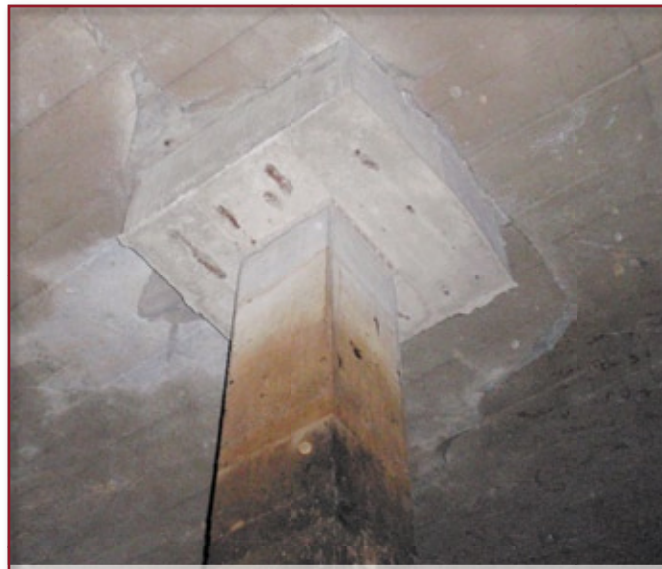
Zbiornik nr 1 – głowica żelbetowego słupa środkowego
