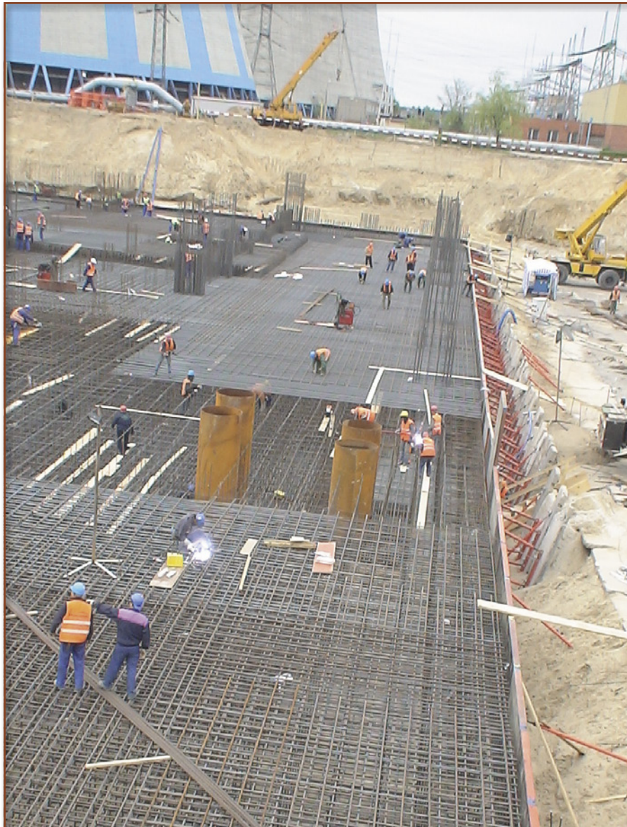
Rys. 7. Faza robót zbrojarskich i wykonanie szalunku
