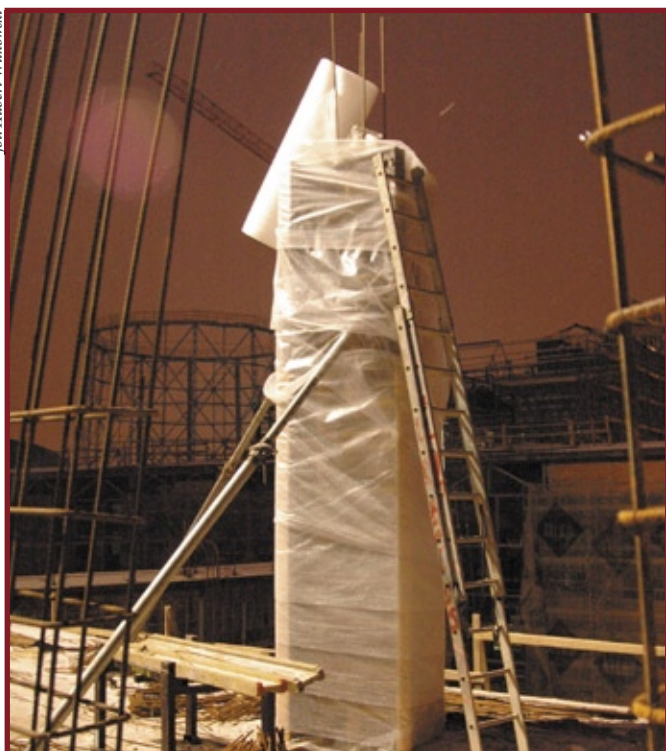
Zabezpieczenie słupa folią „bąbelkową” po pielęgnacji elektronagrzewem chroniące przed szokiem termicznym na budowie EC 1 Wschód
