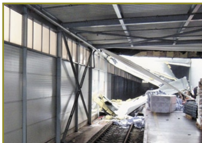
Fot. 2. Widok miejsca awarii budowlanej od strony wnętrza obudowy rampy.
