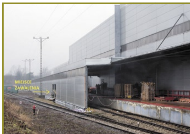
Fot. 1. Widok ogólny rampy kolejowej z obudową i zadaszeniem.
