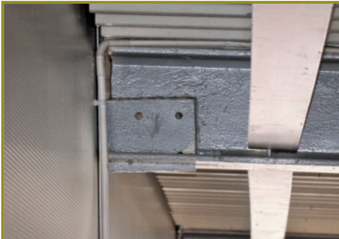
Fot. 5. Przykład braku dopasowania pionowej blachy węzłowej i rygla zadaszenia (połączenie wykonano jako spawane).
