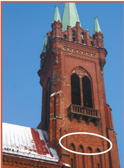
Ryc. 10. Uszkodzenia elewacji wieży od strony południowej. Zaznaczono miejsca zmiany materiałów elewacyjnych
