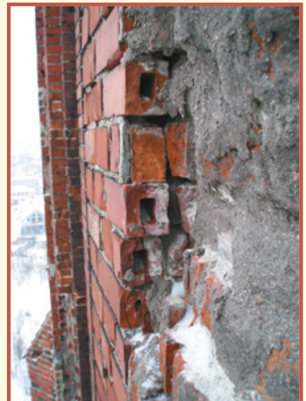
Ryc. 12. Szczegół mocowania elewacji do warstwy nośnej muru
