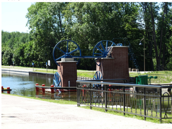
Fot. 7 Urządzenia techniczne kanału
