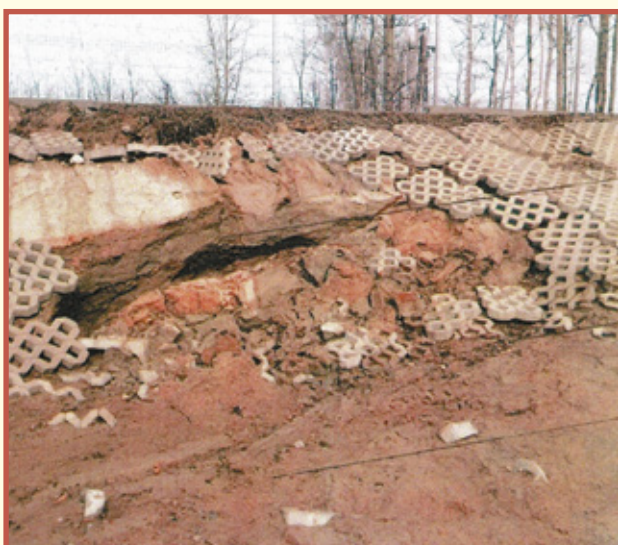
Fot. 3. Zdjęcie wykonane podczas wizji lokalnej 17 marca 2017 r. Ogólny widok rozmycia północno-zachodniej skarpy
