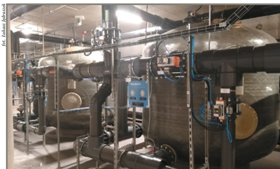
Filtry ciśnieniowe w układzie filtracji zbiornika rekina
