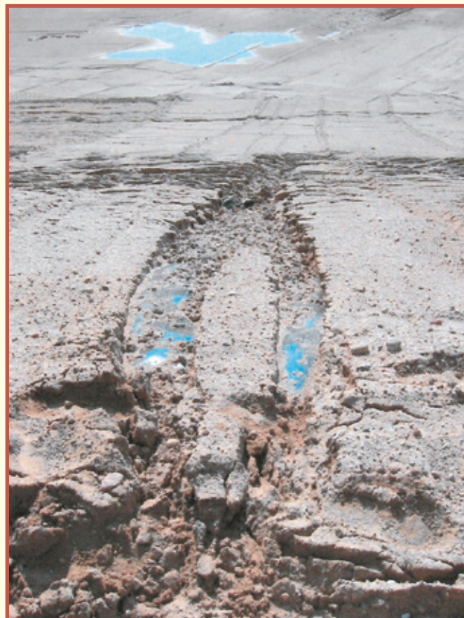
Fot. 5. Rozsunięte zakłady sąsiednich pasów geowłókniny oraz poziome „pofalowania” warstwy pospółki
