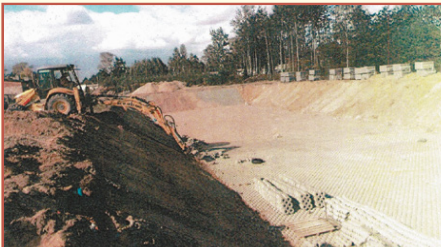
Fot. 1. Zdjęcie archiwalne wykonane we wrześniu 2016 r. Skarpa północno-zachodnia w miejscu awarii już częściowo pokryta ażurowymi płytami betonowymi. Na żadnej skarpie nie widać wpływu lub sączenia wody
