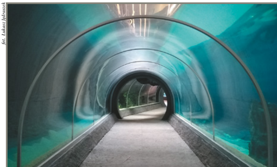
Podwodny tunel akrylowy pod zbiornikiem rekinów
