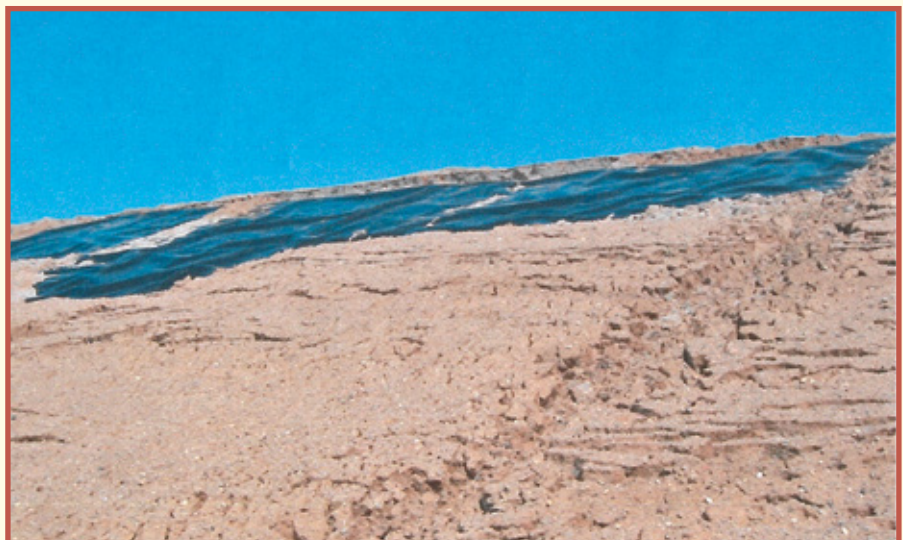
Fot. 6. Odślonięty obszar folii PEHD po wyrwaniu z rowu kotwiącego pasów geowłókniny. Widoczne „pofalowania” warstwy pospółki
