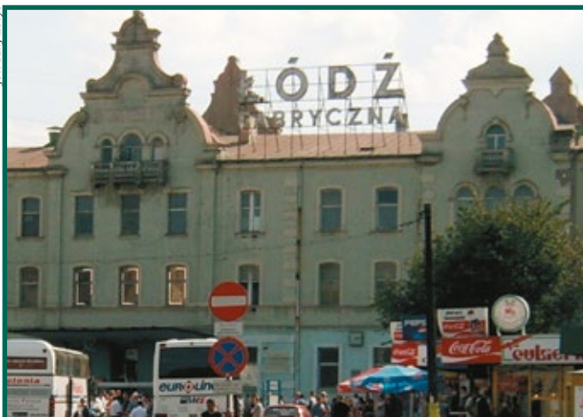
Dworzec Łódź Fabryczna przed remontem – 2005 r.
