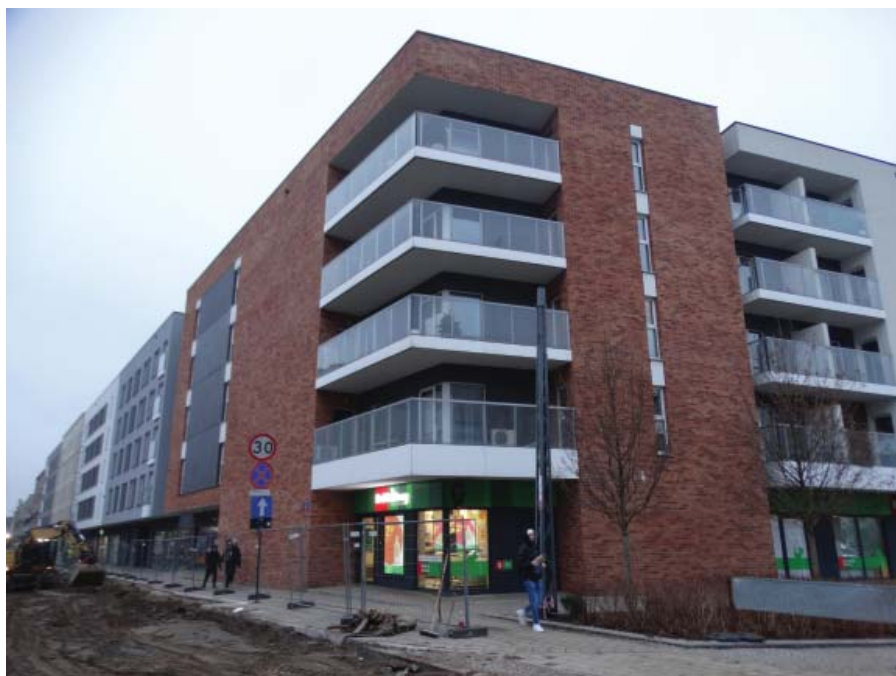
Kompleks budynków mieszkalnych przy ulicy Legionów 66 Autor zdjęcia: Wiesław Kaliński
