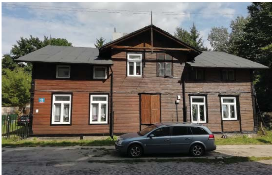
Łódź. Drewniany budynek po konserwacji i remoncie Autor zdjęcia: Mariusz Gaworczyk
