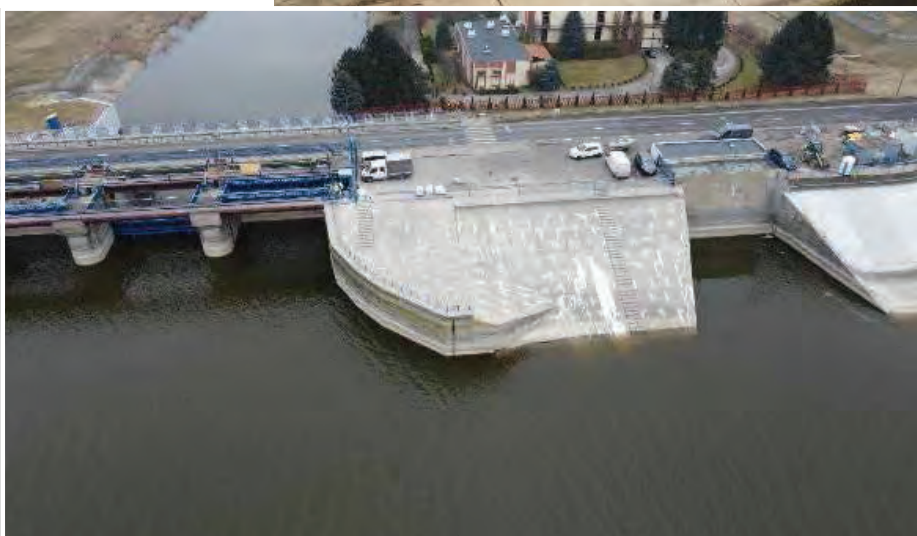
◀ Widok z drona na wykonaną iniekcję na prawym przyczółku jazu
