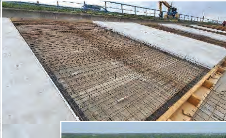
▶ Widok z drona na prowadzone betonowanie płyt parzystych I rzędu płyt - prawa strona zapory
