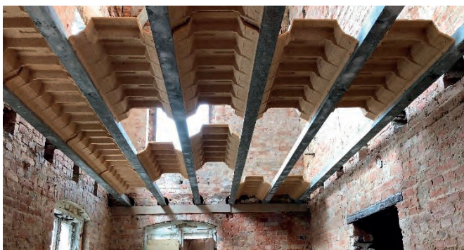
Fot. Montaż belek w gniazdach
