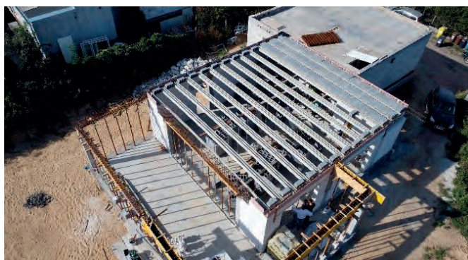
Fot. Dom jednorodzinny – montaż belek o długości 970 cm
