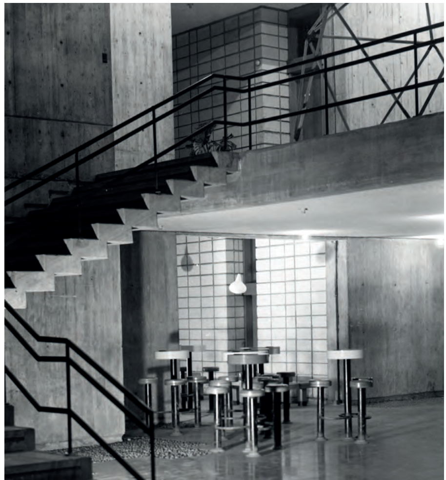
Fot. 4. Fasada budynku oraz foyer wydziału Architektury Uniwersytetu Technicznego w Ankarze Źródło: Flickr, Salt Research photostream, https://www.flickr.com/photos/saltonline/with/14826812696/
