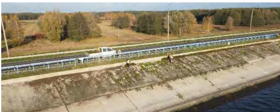
▶ Czyszczenie ręczne ekranu zapory z porostów
