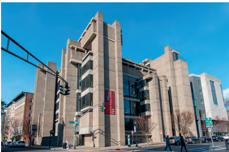
Fot. 2. Widok na fasadę budynku Rudolph Hall
