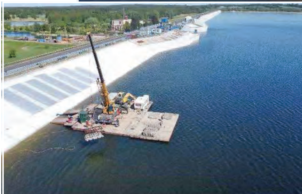
◀ Widok z drona na prowadzone prace przy topieniu materaców gabionowych
