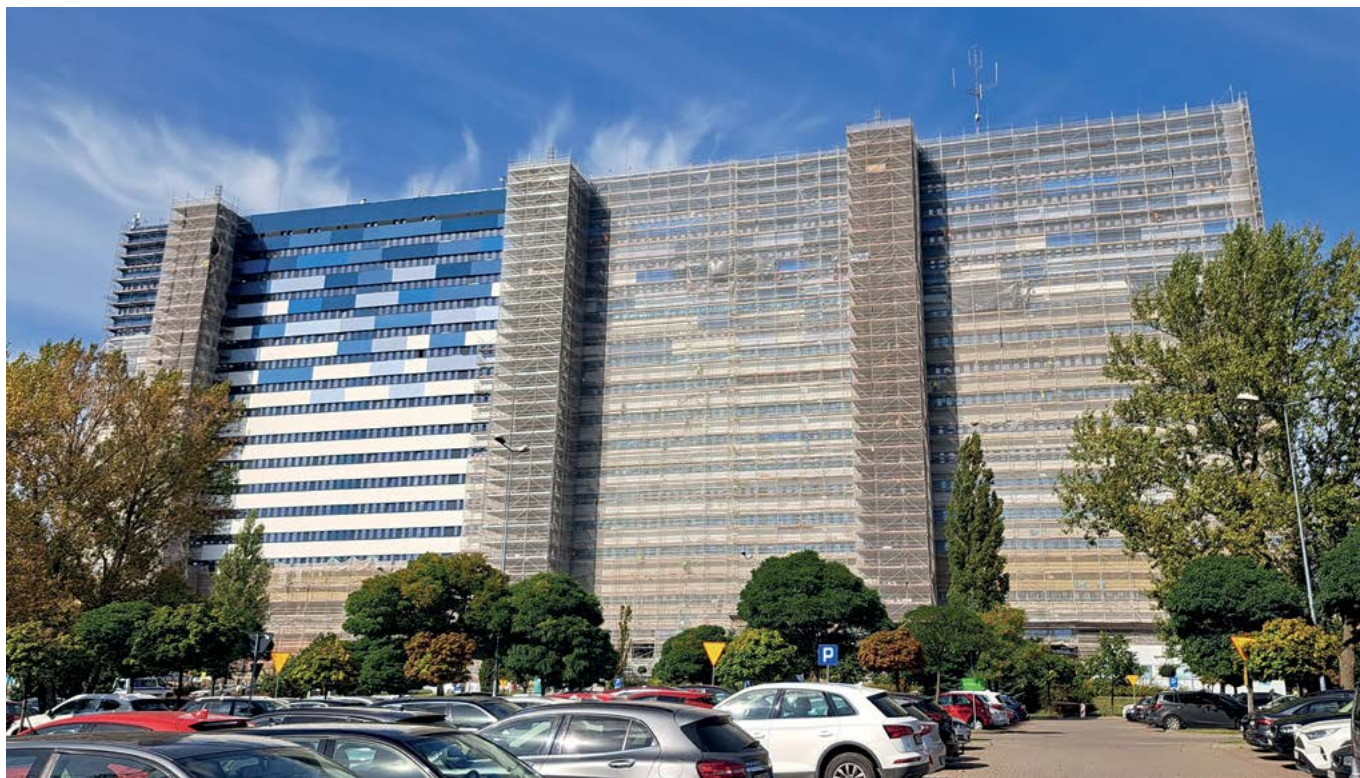
Fot. 4. Budynek A1 Centrum Kliniczno-Dydaktycznego Uniwersytetu Medycznego w Łodzi z częściowo zmodernizowaną elewacją Źródło zdjęć: Strona Zab-Bud Sp. z o.o., https://zab-bud.pl/gleboka-termomodernizacja-strategicznego-budynku-kampusu-centrum-kliniczno-dydaktycznego-universytetu-medycznego-w-lodzi/
