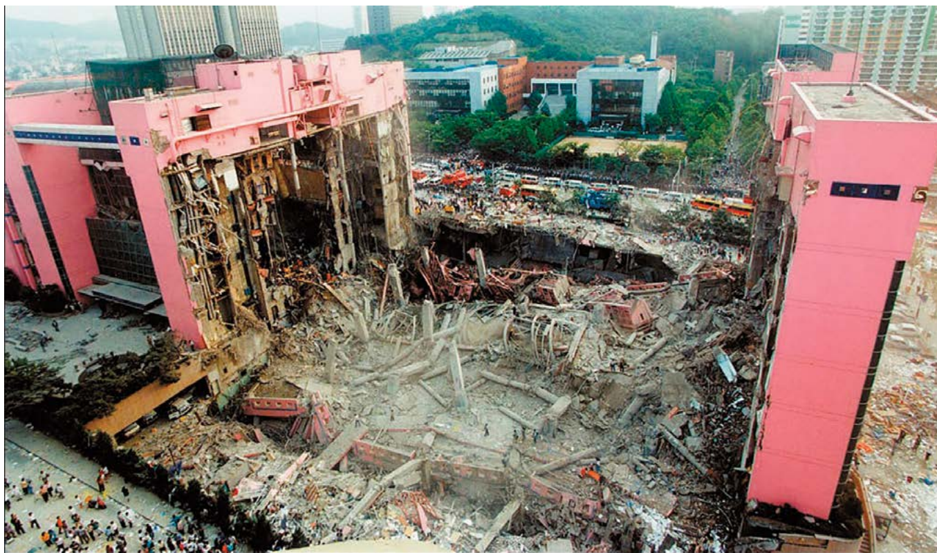
Zawalenie się centrum handlowego w Seulu
