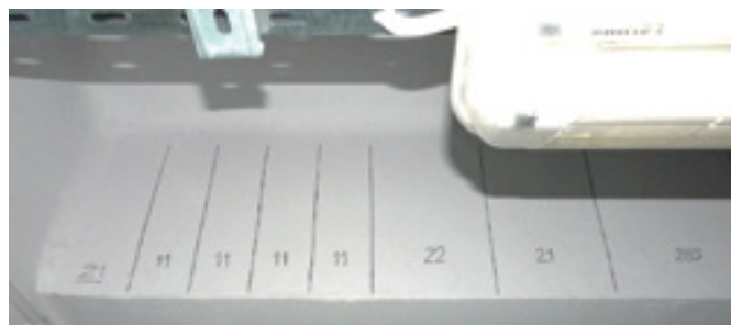
Rys. 7. Przykład pomiaru rozstawu strzemion w żebrze Ż1
