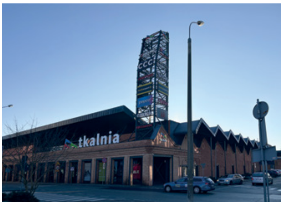
Fot. 4. Elewacja sali koncertowej widok od ul. Grobelnej. Autor zdjęcia: Emilia Dąbek
