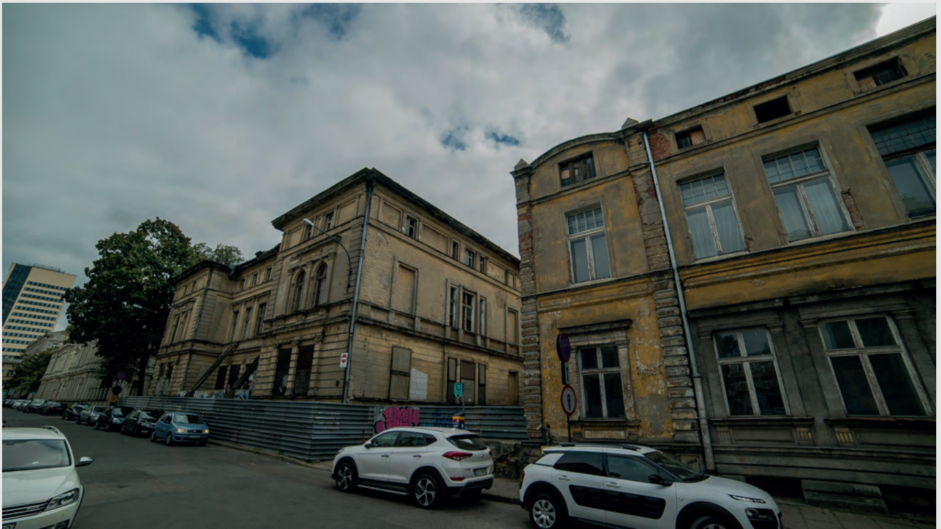
Rys. 4. Budynek przed rozpoczęciem prac budowlanych
