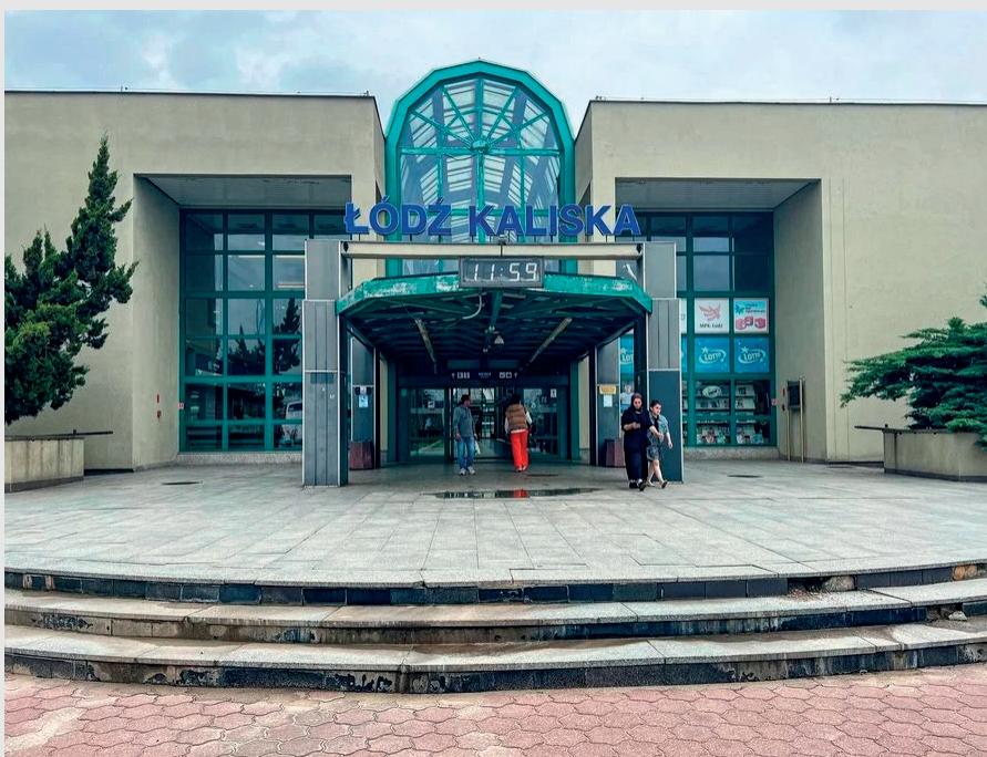
Rys. 4. Dworzec przed remontem, źródło: lodz.pl
