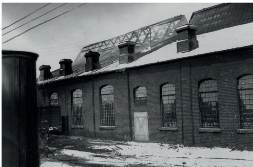
Rys. 1. Widok zewnętrzny budynku parowozowni, źródło: Narodowe Archiwum Cyfrowe
