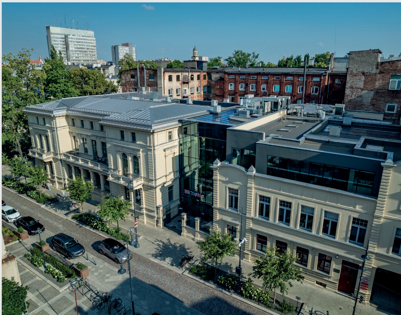
Rys. 3. Cały budynek z widocznym szklanym zadaszeniem
