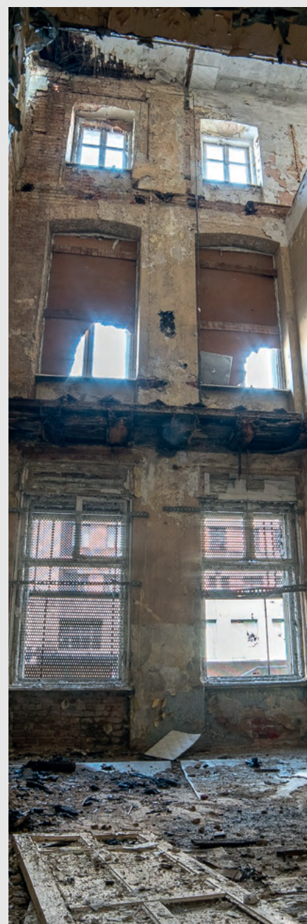
Rys. 2. Stan obiektu przed rekonstrukcją – widoczny brak stropów drewnianych
