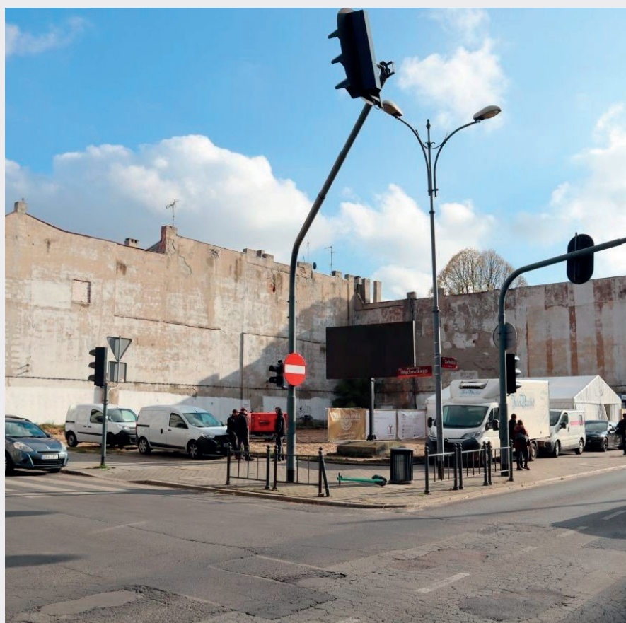
Fot. 2. Pustostan na rogu ul. Zachodniej i ul. Więckowskiego – przed rozpoczęciem budowy, fot. Krzysztof Szymczak
