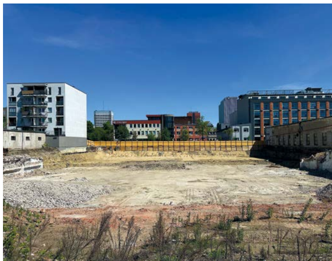
Fot. 1. Plac budowy w centrum miasta
