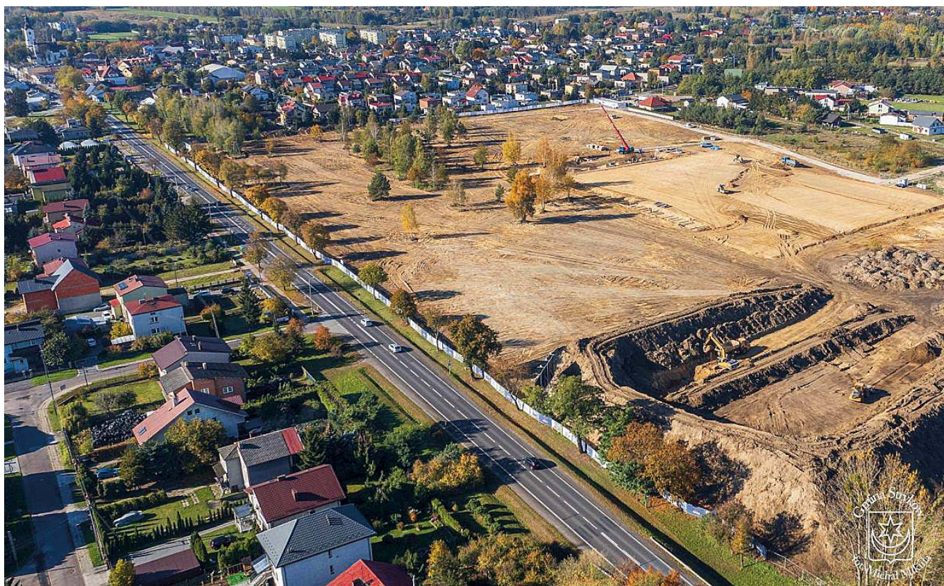
Rozpoczęcie budowy CRS (2024 rok), fot. Michał Mikuła 3 PHOTO
