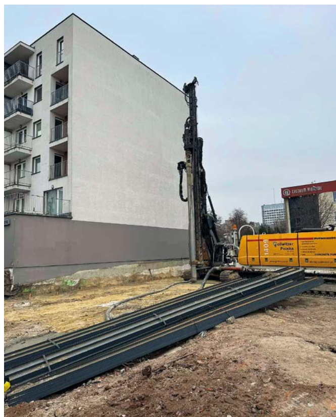
Fot. 2. Palownica wykorzystywana do wznoszenia pali CCFA
