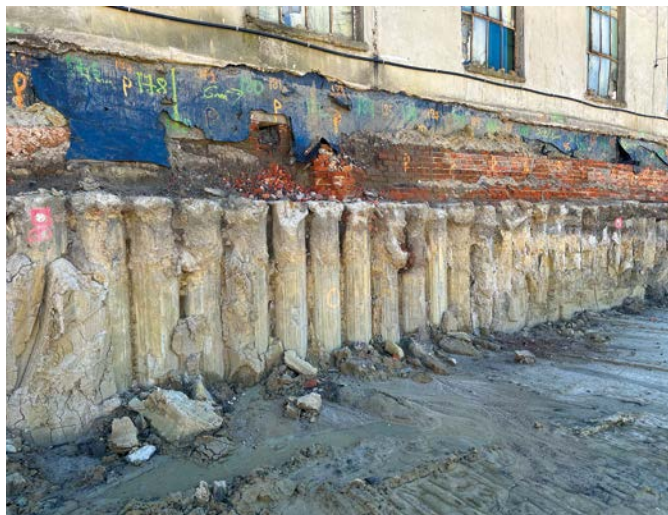
Fot. 3. Gotowe pale CCFA w sąsiedztwie istniejących fundamentów z cegły pełnej
