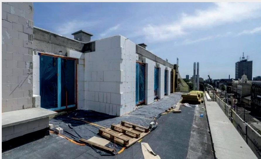
Fot. 1. Budowa Białej Kamienicy, fot. UMŁ
