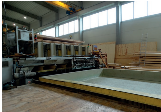
Rychłowice – wnętrze hali produkcyjnej CLT Witkowsy
