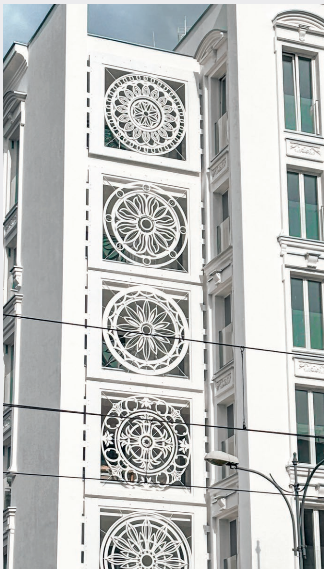
Fot. 5. Rozety na elewacji, fot. Karolina Włodarczyk
