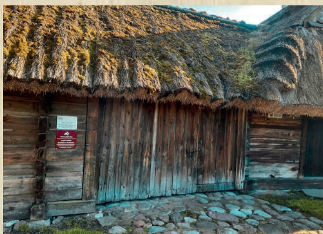
Fot. 4. Detal konstrukcji drewnianej oraz pokrycia dachowego
