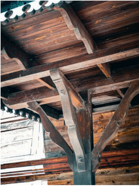
Fot. 3. Fragment konstrukcji zadaszenia nad wejściem
