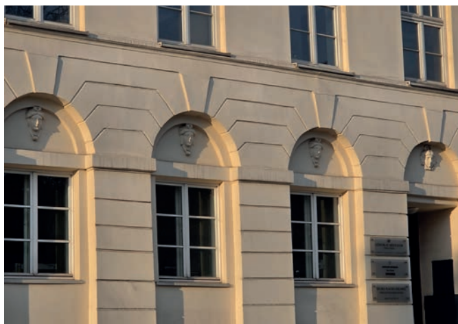
Fot. 2. Detale architektoniczne budynku (ul. Długa 33)
