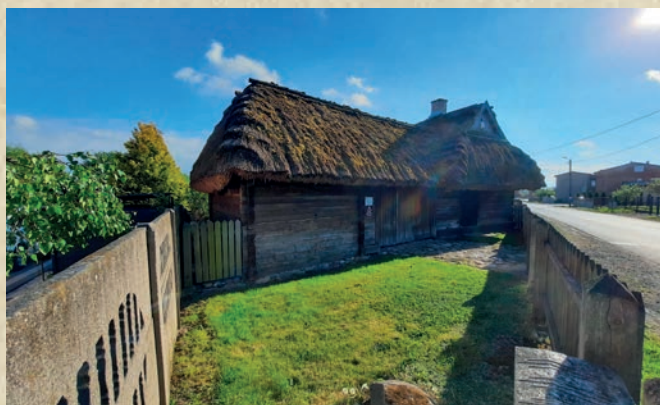
Fot. 3. Widok zabytkowego budynku od strony podwórza
