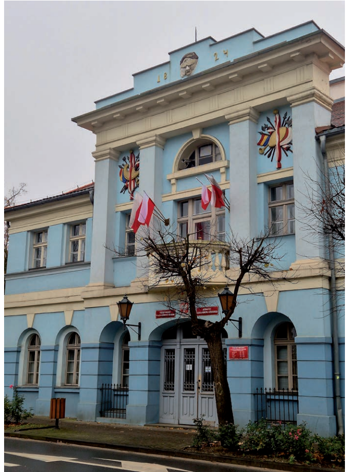
Fot. 1. Elewacja frontowa ratusza, listopad 2025 r., fot. Katarzyna Justyńska
