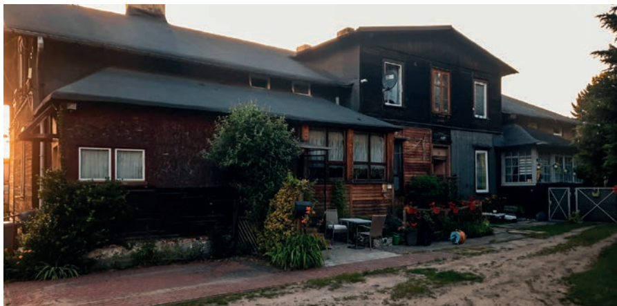
Jeden z drewnianych budynków mieszkalnych
