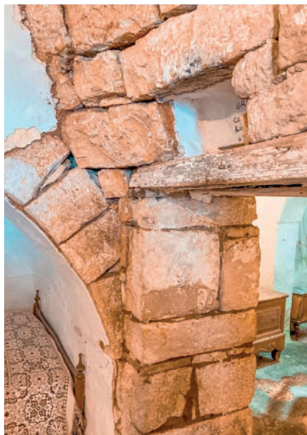
Fragment wewnętrznej konstrukcji trullo wykonanej w technice suchego muru
