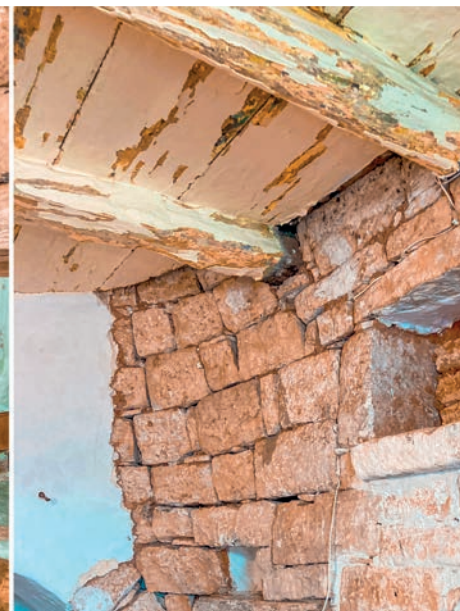
Fragment wewnętrznej konstrukcji trullo wykonanej w technice suchego muru
