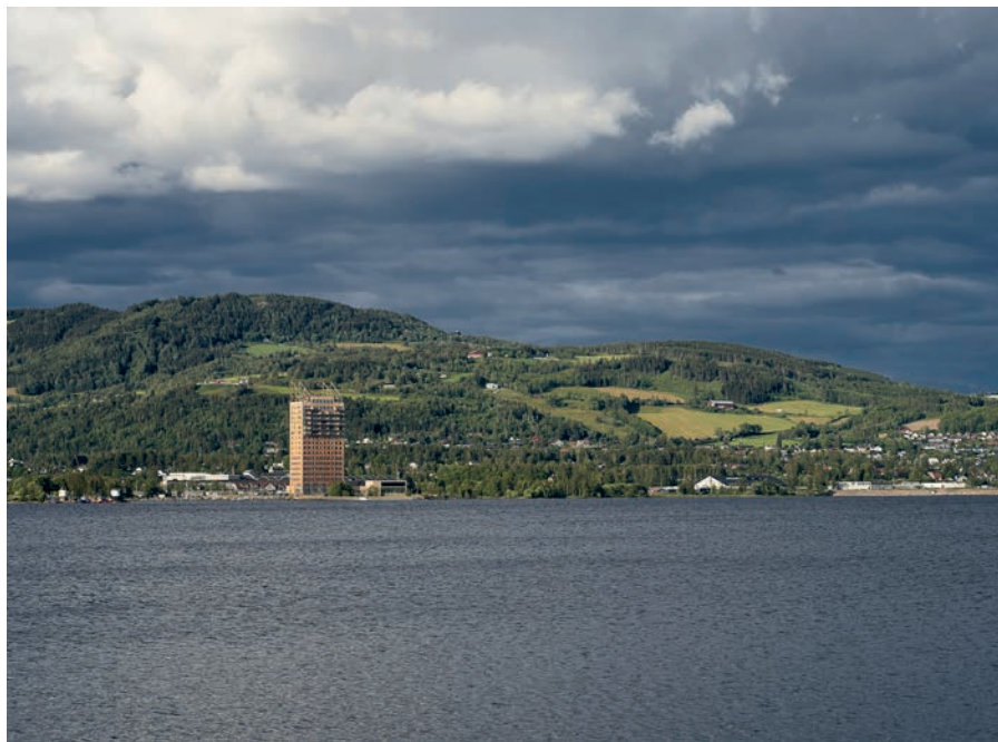
Widok na Mjøstårnet nad jeziorem Mjøsa, fot. Øyvind Holmstad, Wikimedia Commons, CC BY-SA 4.0
