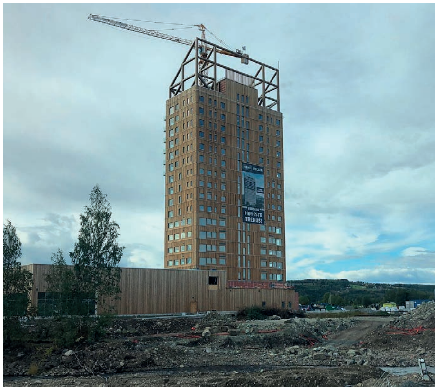
Drewniany wieżowiec Mjøstårnet w trakcie budowy, fot. Bjoertvedt, Wikimedia Commons, CC BY-SA 4.0
